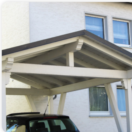
Ortgang mit Schindelortgangblende
